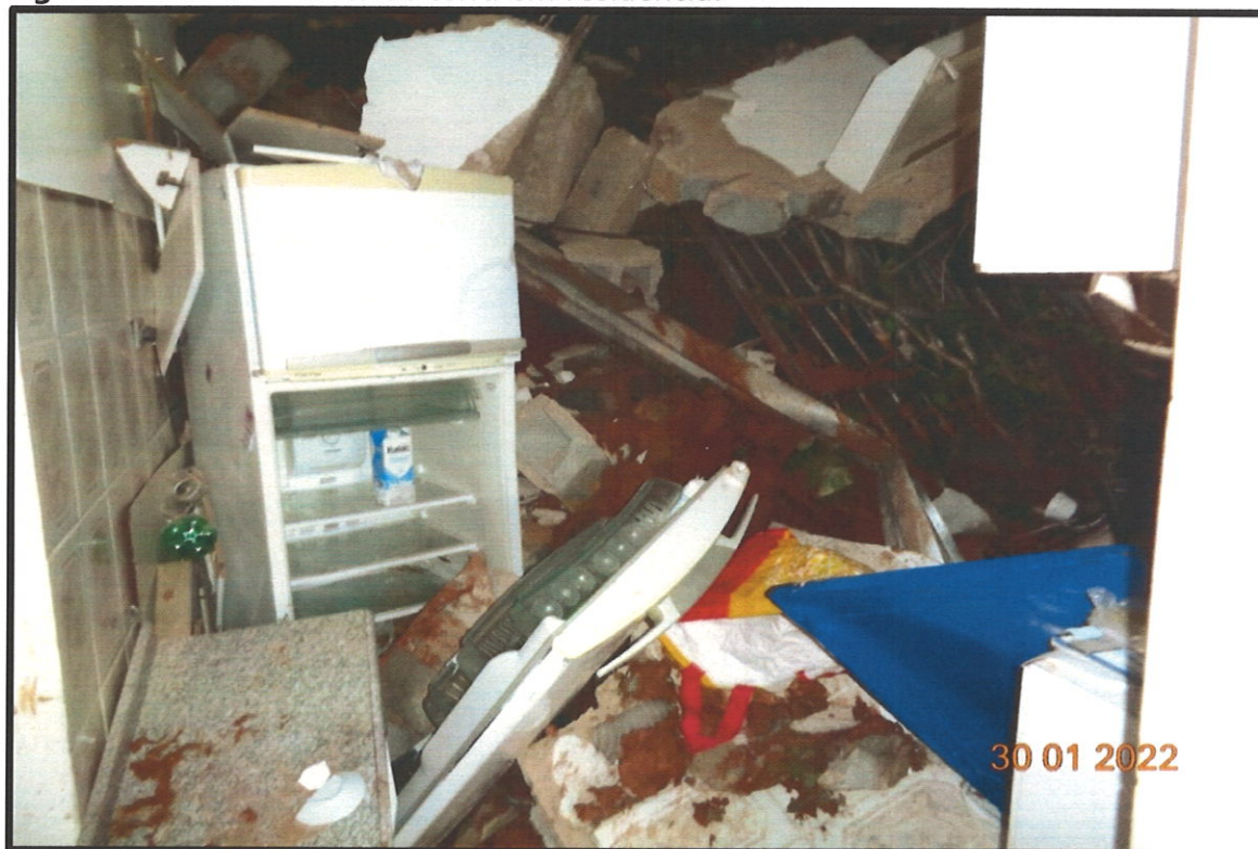
Figura 2 – Deslizamento de terra em residência.
