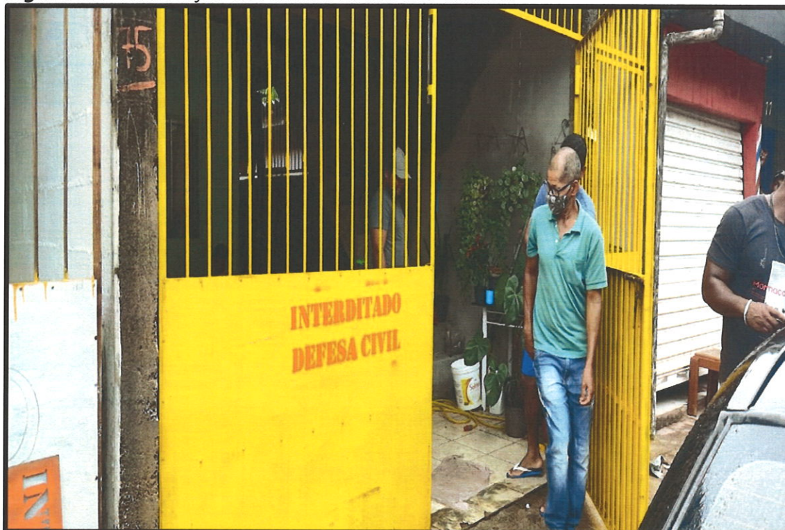
Figura 11 – Interdição de Moradia no Jd. São Camilo.
