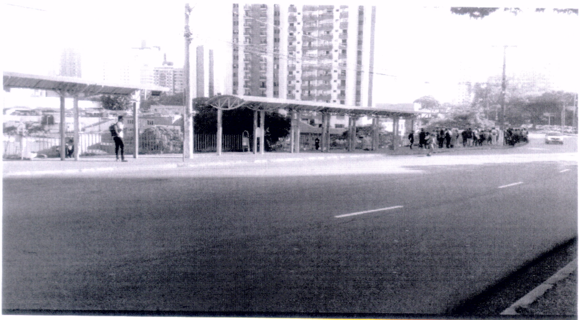
Foto 2 – Vista do ponto e do viaduto
