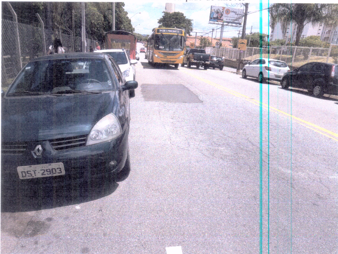
Reparo de asfalto recente
