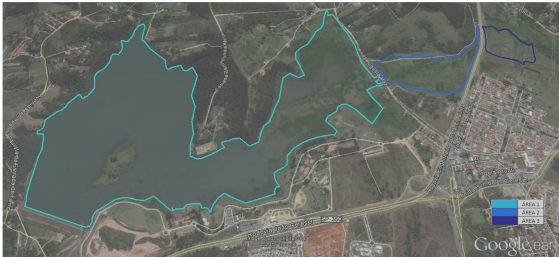
Figura 7.1 – Represa de Acumulação – Parque da Cidade
