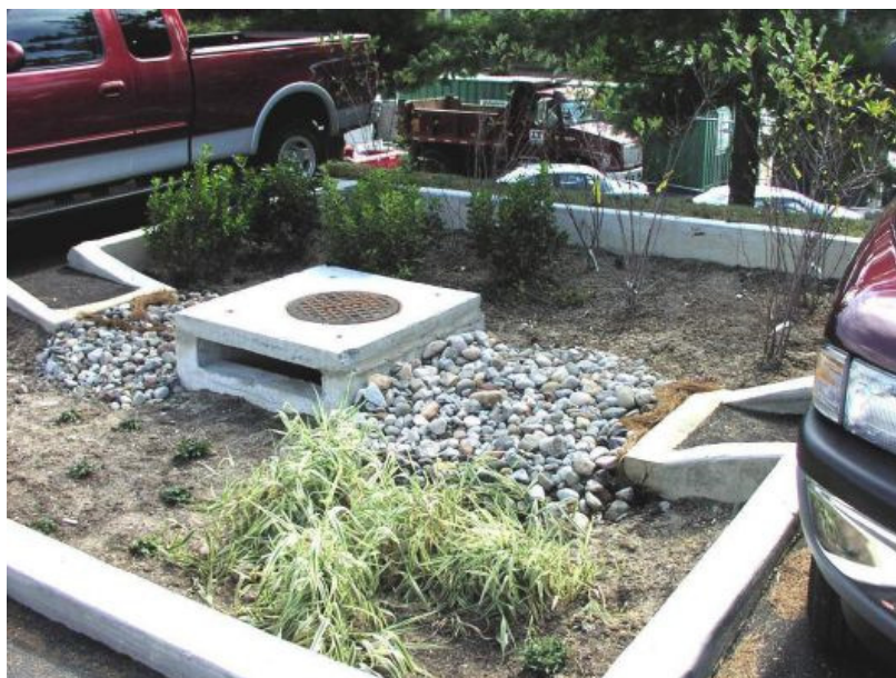
Figura 7.13 – Exemplo de Bioretenção
