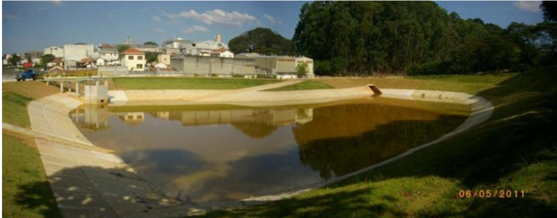
Figura 7.25 - Bacia de retenção no cemitério da Vila Formosa
