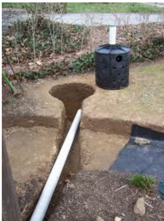
Figura 7.14 – Poço seco em construção
