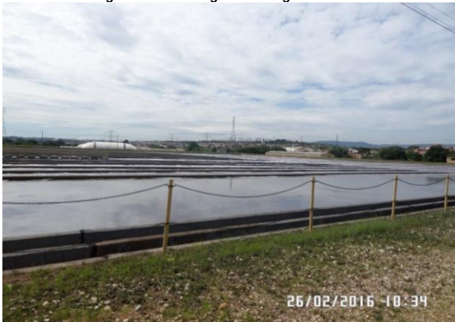
Figura 4.15 - Vista geral das lagoas aeradas
