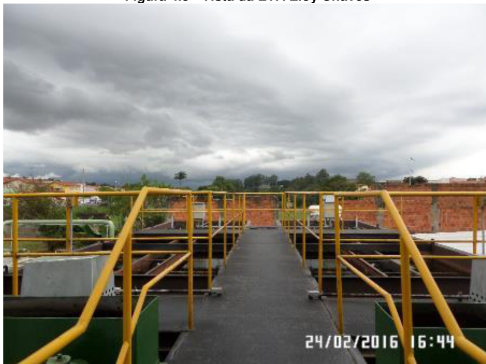
Figura 4.5 - Vista da ETA Eloy Chaves
