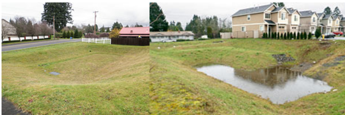
Figura 7.17 – Bacia de infiltração antes e após um evento de chuva
