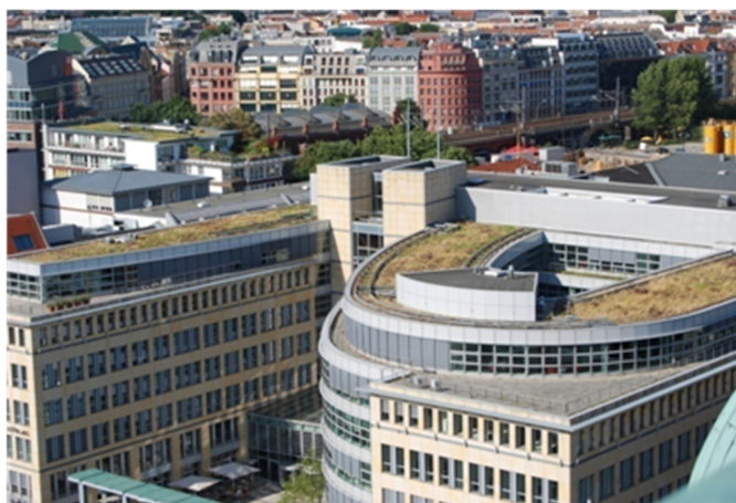
Figura 7.20 – Telhados verdes em área densamente urbanizada em Berlim
