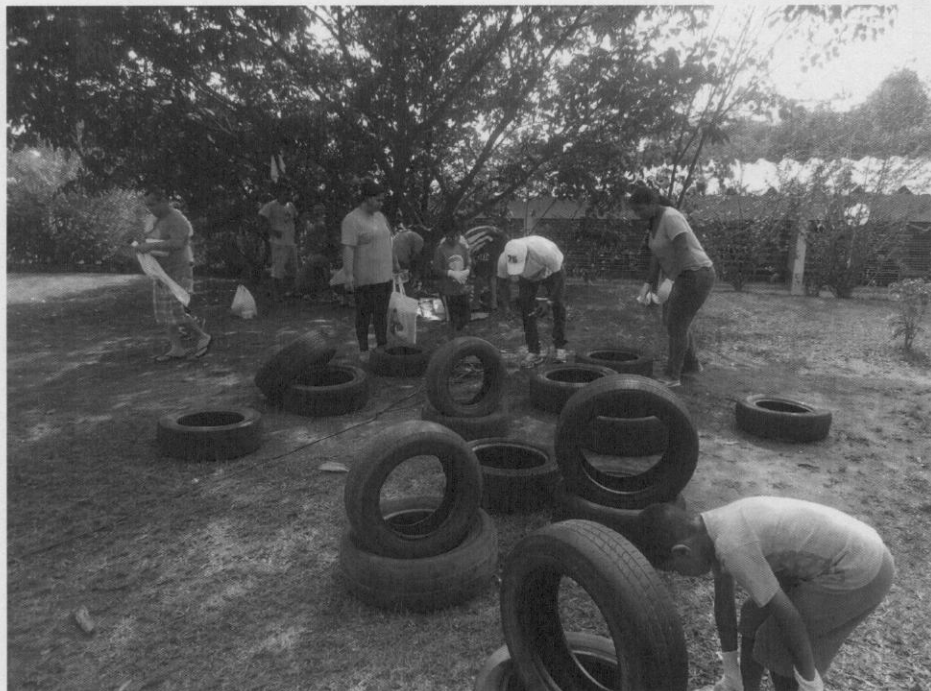
Preparação dos pneus para a construção do parque.
