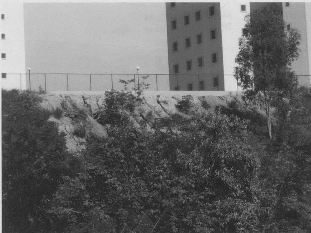
Fig. 02 → talude do Res. Azaleia
