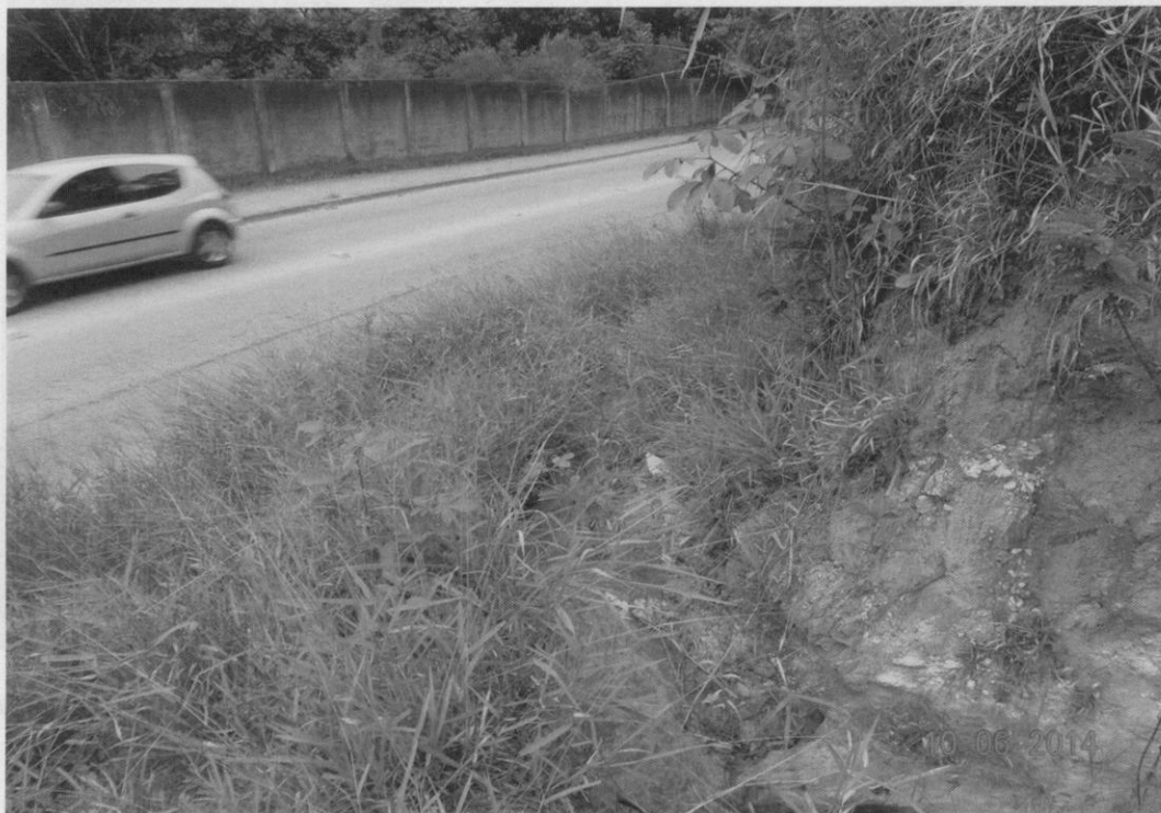
CAMINHAMENTO DAS ÁGUAS PARA A AV. NAÇÕES UNIDAS
