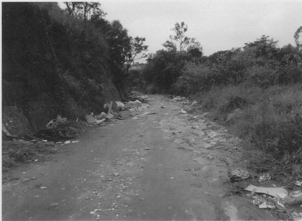
MAIS UMA IMAGEM, MOSTRANDO O ENTULHO E A ÁGUA ESCOANDO ATRAVÉS DELES
