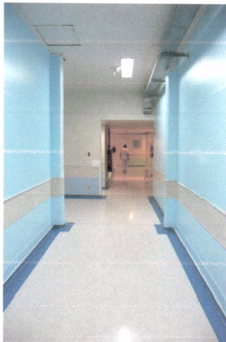
Corredor após pintura
