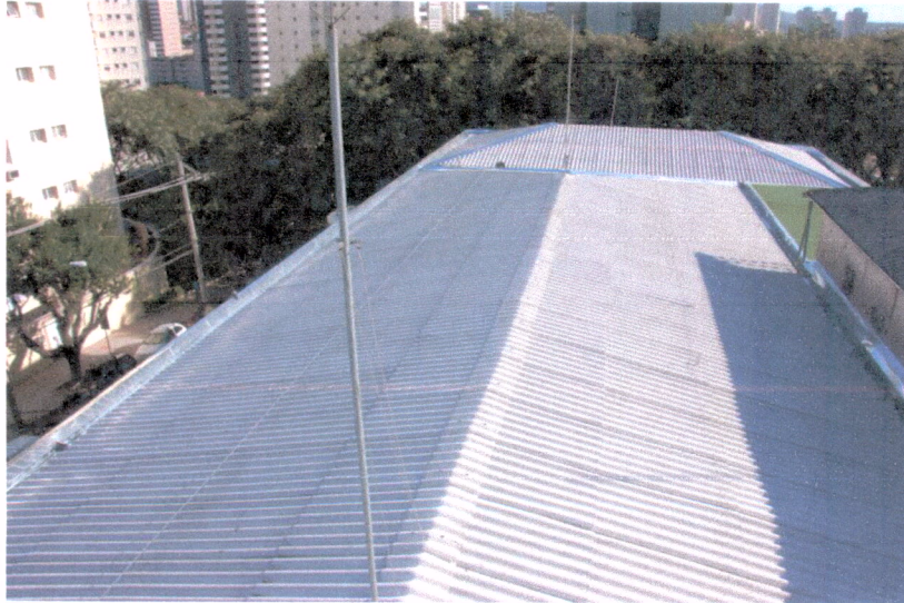
Telhas novas do Centro Cirúrgico
