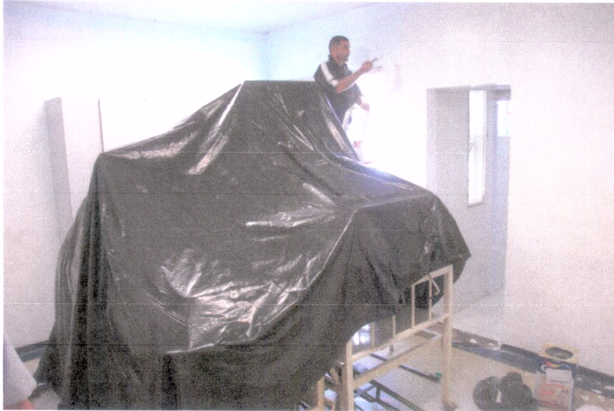
Quarto da clínica Feminina em reforma
