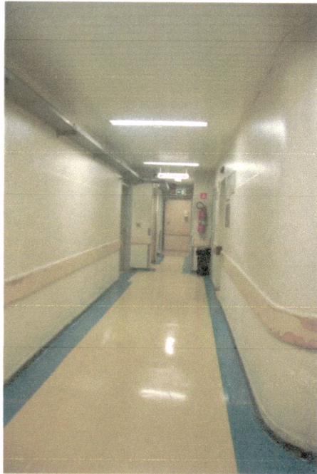
Corredor antes da pintura
