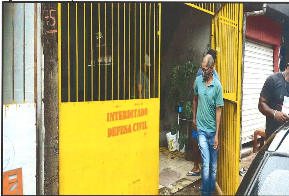
Figura 11 – Interdição de Moradia no Jd. São Camilo.
