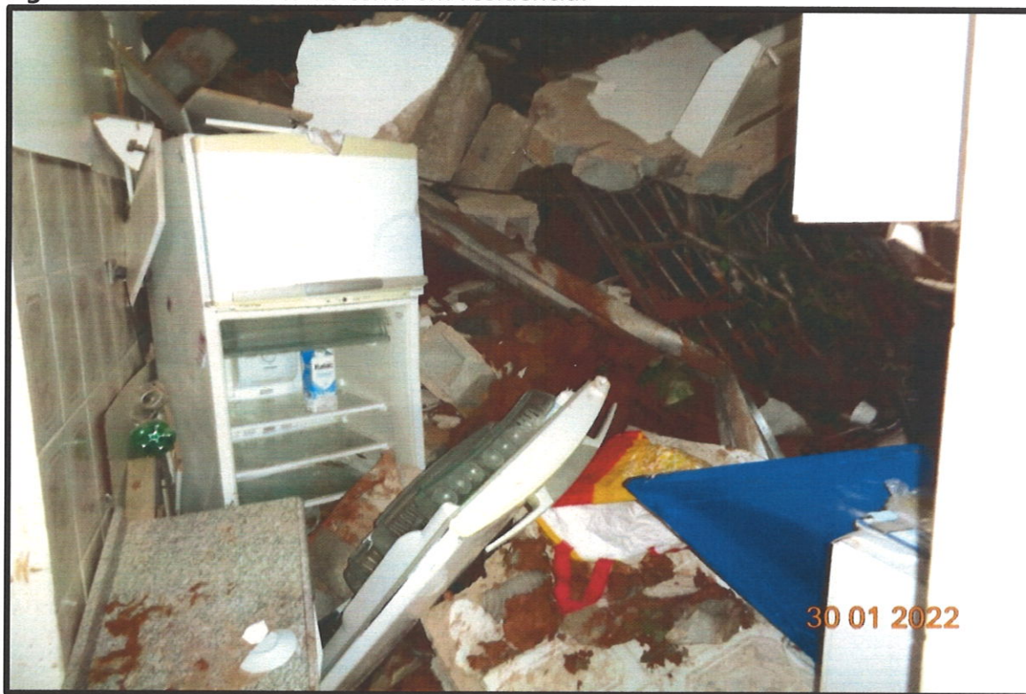
Figura 2 – Deslizamento de terra em residência.
