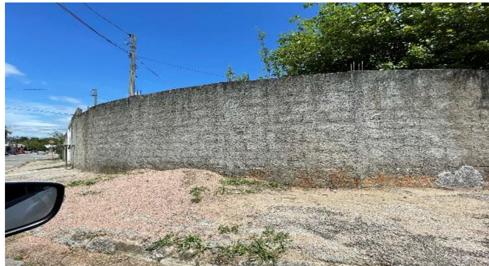
Fotografias de vistoria indicando situação atual da área pública analisada.
