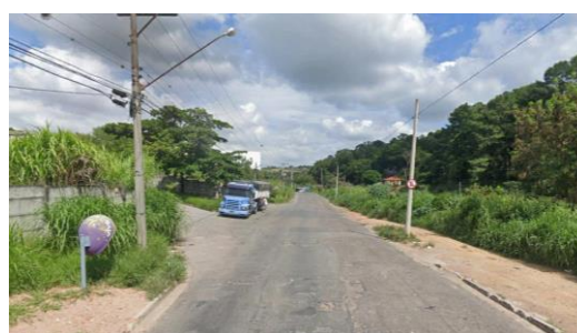
Figura 121: Exemplo de via com histórico de problemas de circulação de veículos de carga (Av. Beta – Bairro do Poste)
