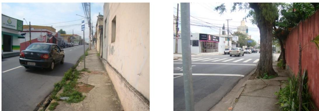
**Figura 12: Exemplos de má conservação de pavimentos e ausência de padronização em calçadas**
