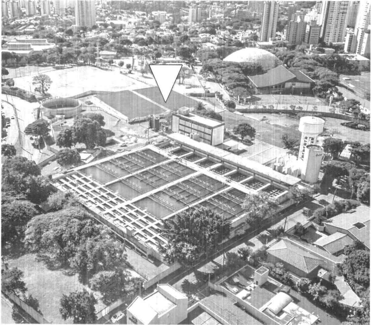
Novo reservatório ETA Anhangabaú, capacidade de armazenamento de 10 milhões de litros de água tratada
