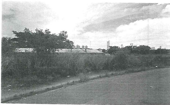
Vista do Imóvel
