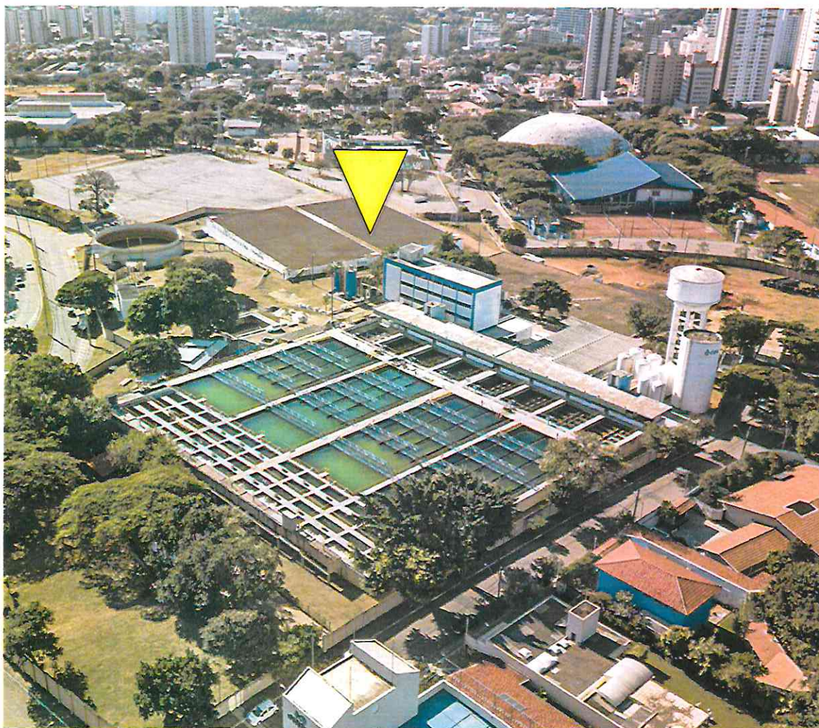
Novo reservatório ETA Anhangabaú, capacidade de armazenamento de 10 milhões de litros de água tratada
