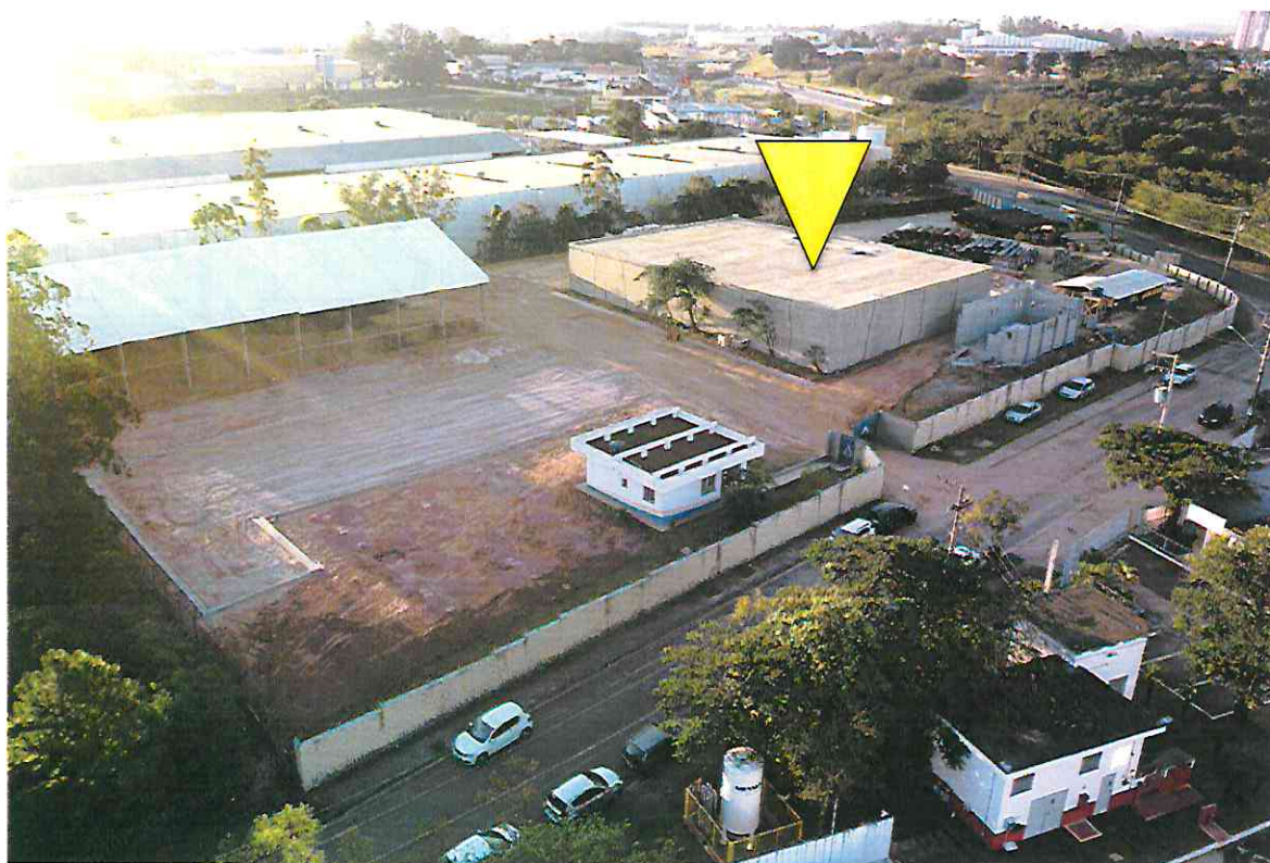
Reservatório do R13 está localizado no Distrito Industrial
