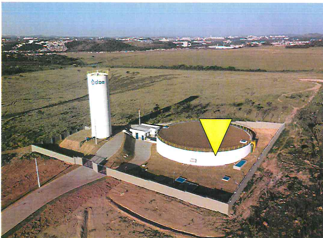
Reservatório do FazGran vai ampliar em 5 milhões de litros a reservação de água tratada para a região
