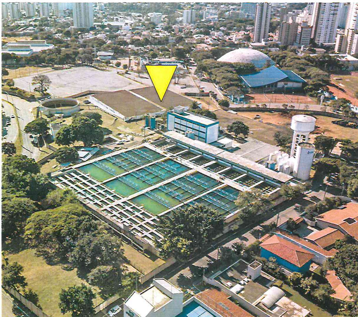
Novo reservatório ETA Anhangabaú, capacidade de armazenamento de 10 milhões de litros de água tratada
