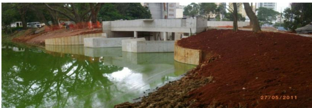
Figura 7.24 - Vertedor Labirinto no Lago da Aclimação
