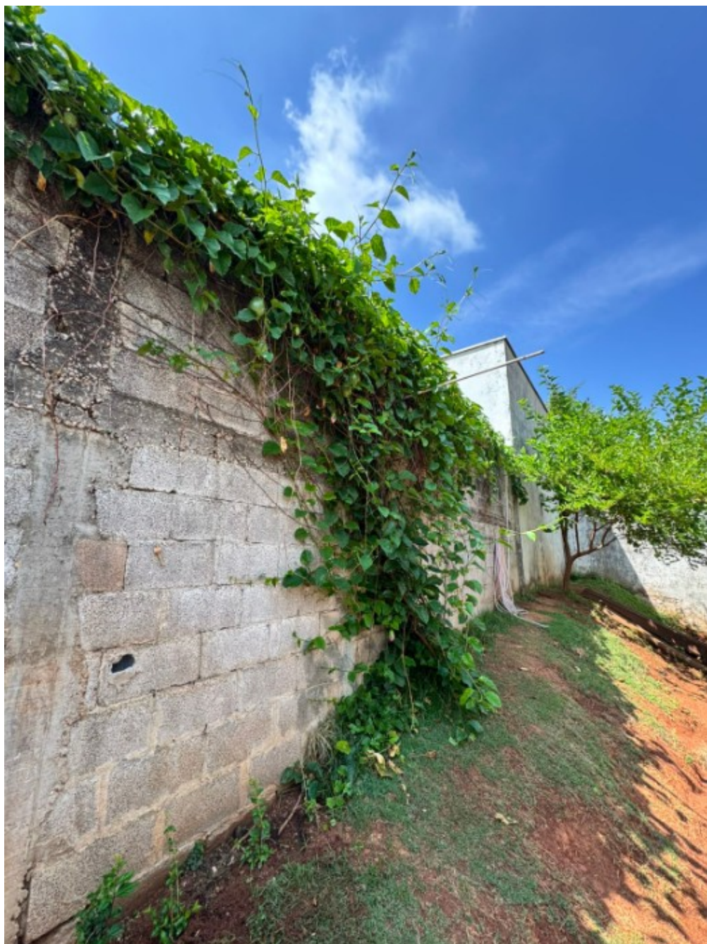
Pintura e reboque de muro
