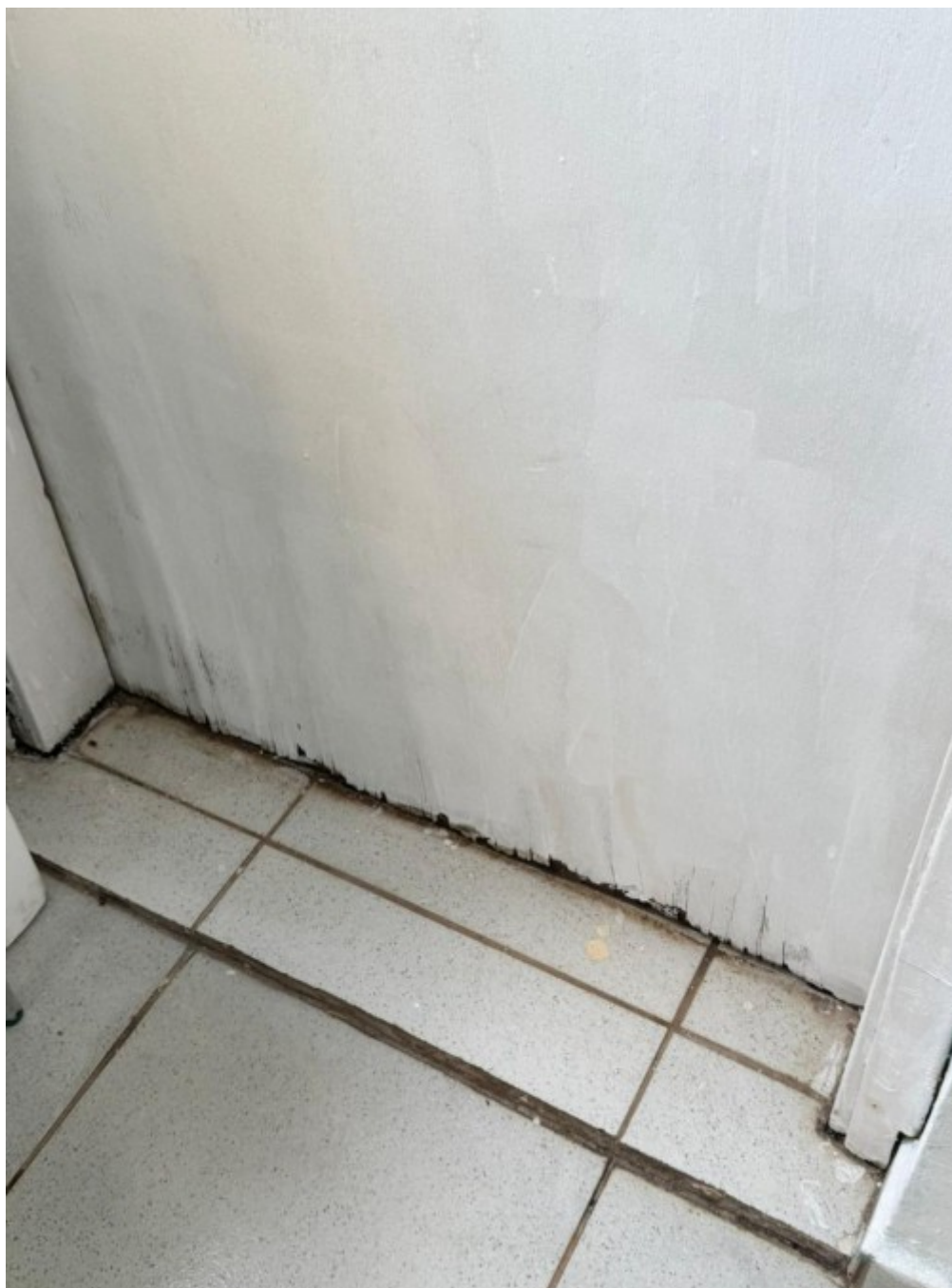
Troca de diversas portas que estão condenadas
