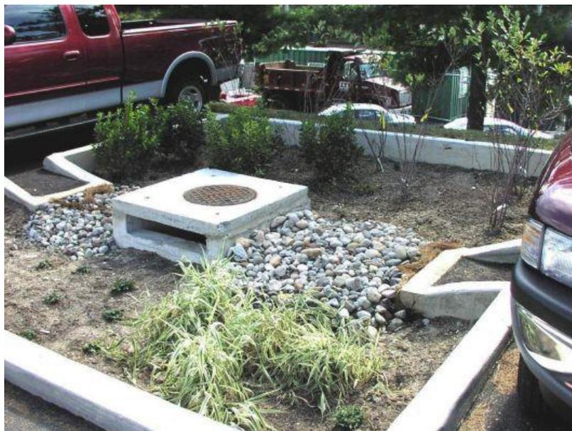
**Figura 7.13 – Exemplo de Bioretenção**
