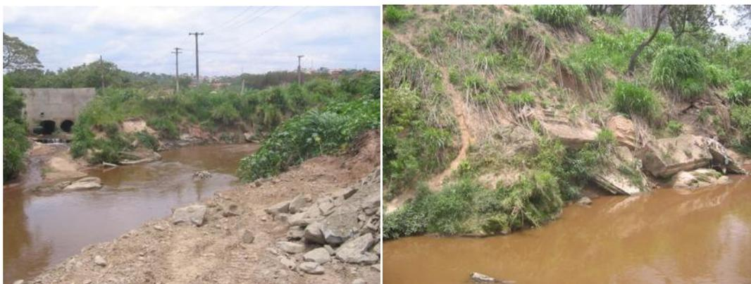
**Figura 6.3 - Rio Jundiá – Presença de assoreamento, entulho e deslizamentos**
