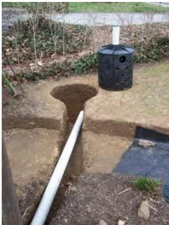
**Figura 7.14 – Poço seco em construção**
