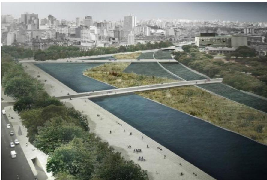
**Figura 7.21 – Perspectiva de alagado construído para o Parque D. Pedro II**
