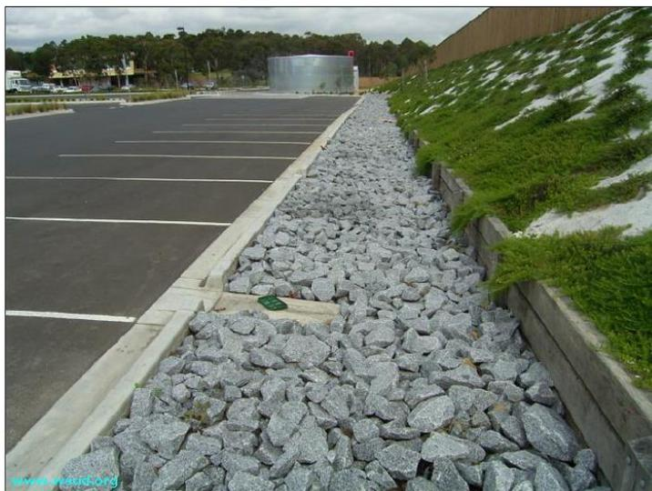
**Figura 7.15 – Trincheira de infiltração**
