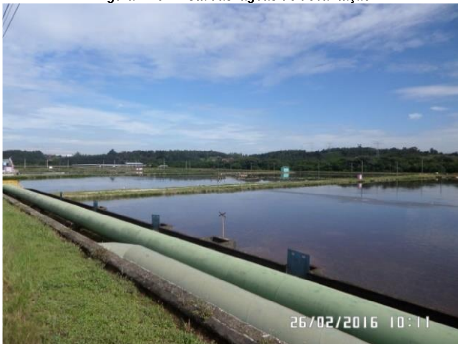
Figura 4.16 - Vista das lagoas de decantação
