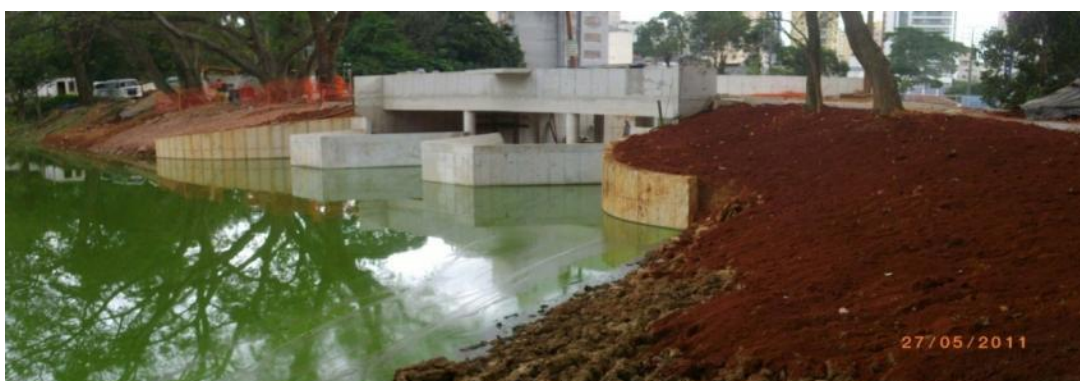
Figura 7.24 - Vertedor Labirinto no Lago da Aclimação
