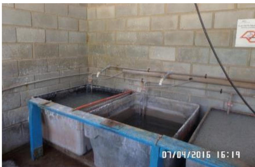
Figura 4.8 - Tanque para preparo de soluções a serem adicionadas no floculador decantador
