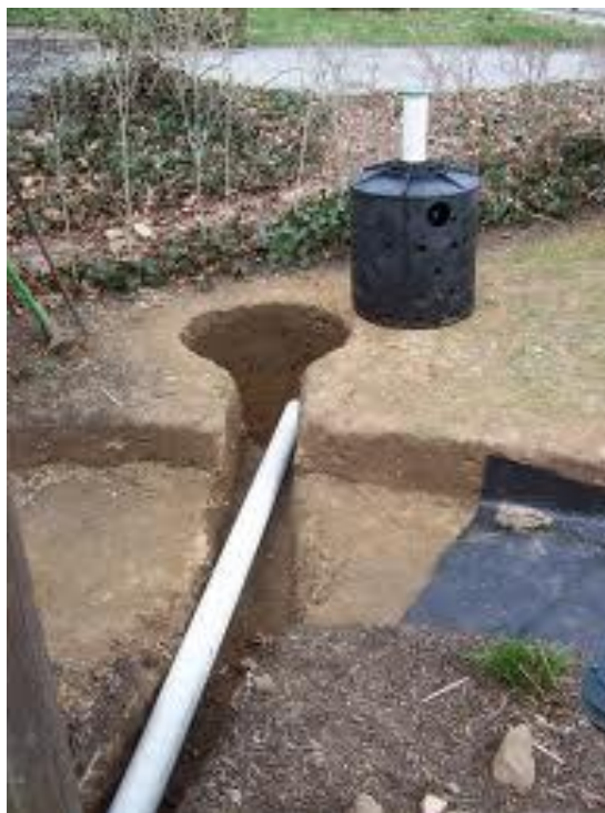
Figura 7.14 – Poço seco em construção
