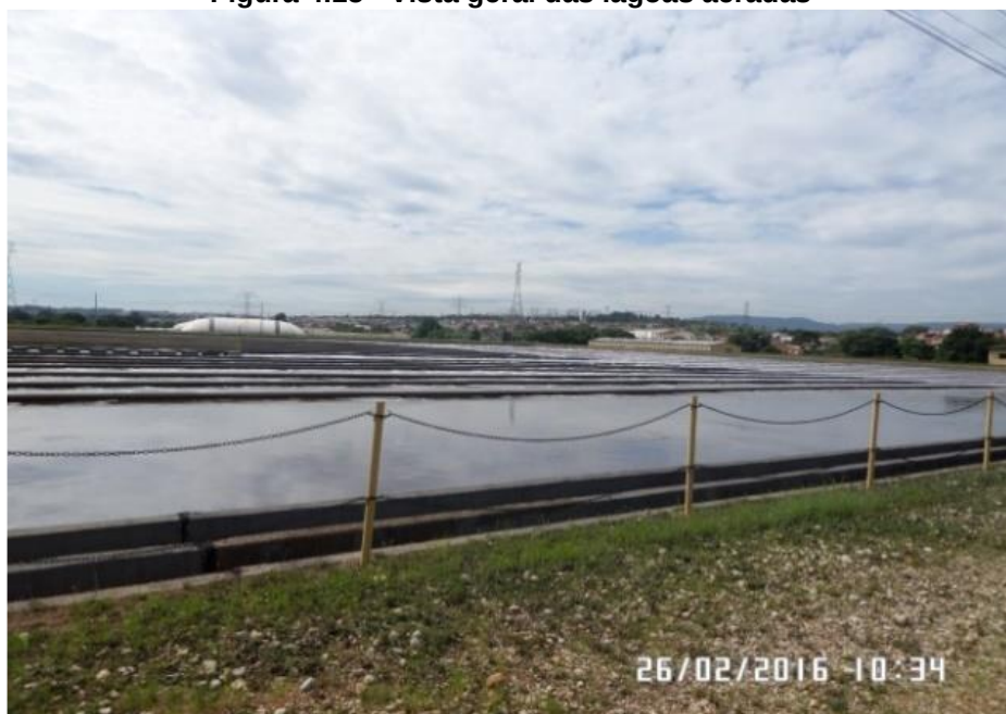
Figura 4.15 - Vista geral das lagoas aeradas
