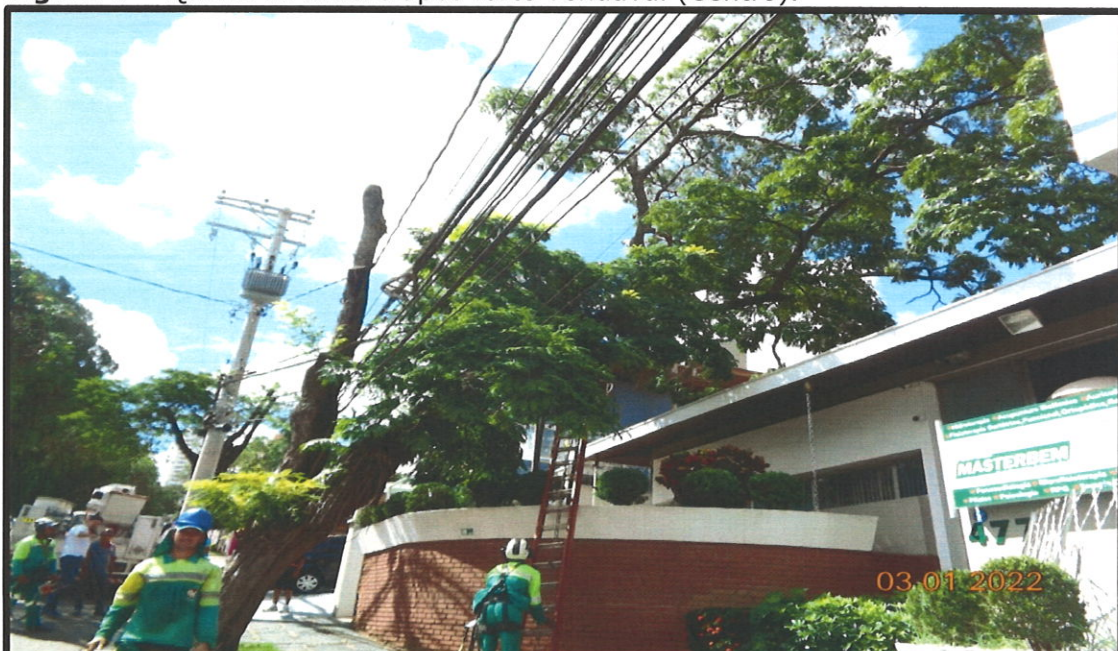
Figura 9 – Queda de árvore após forte vendaval (Centro).
