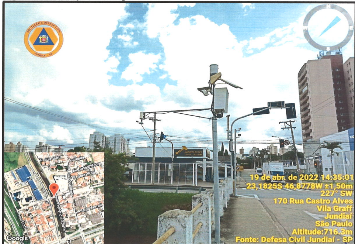
Figura 03 – Estação Hidrológica Rio Jundiaí/ Vila Graff.
