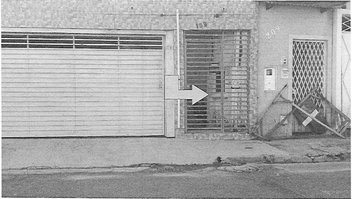
Água invade imóvel através dessa tubulação
