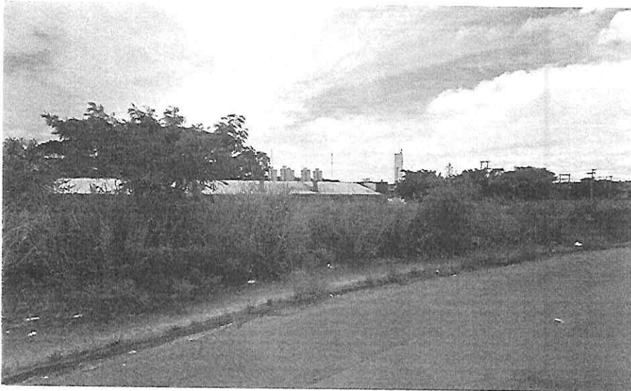
Vista do Imóvel
