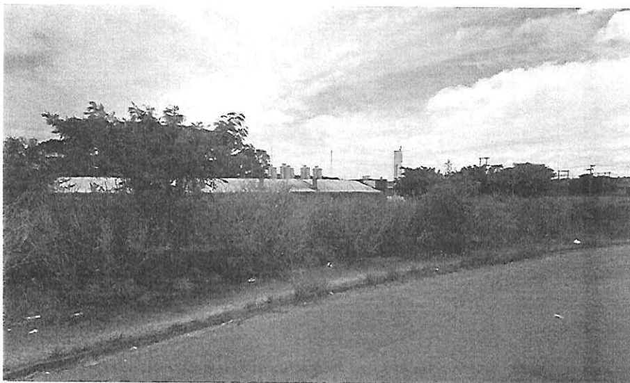
Vista do Imóvel
