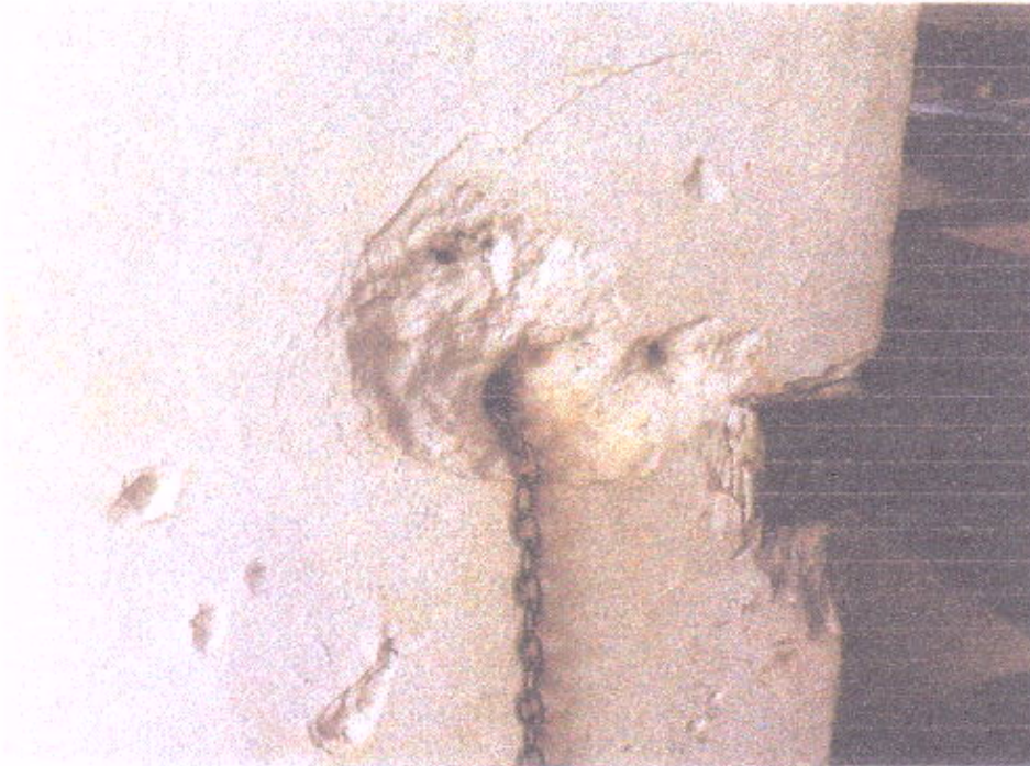
PORTA DE ENTRADA DO GINÁSIO
