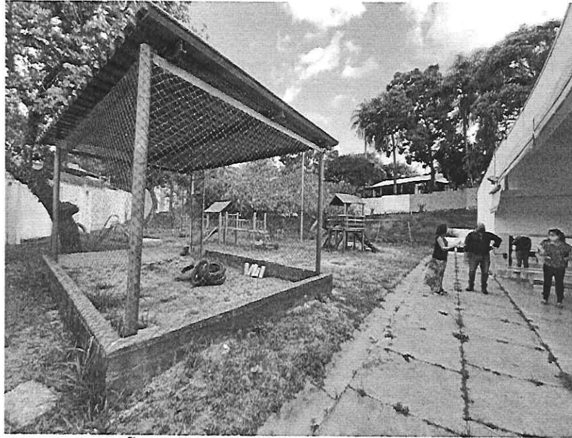
MANUTENÇÃO NO PLAYGROUND
