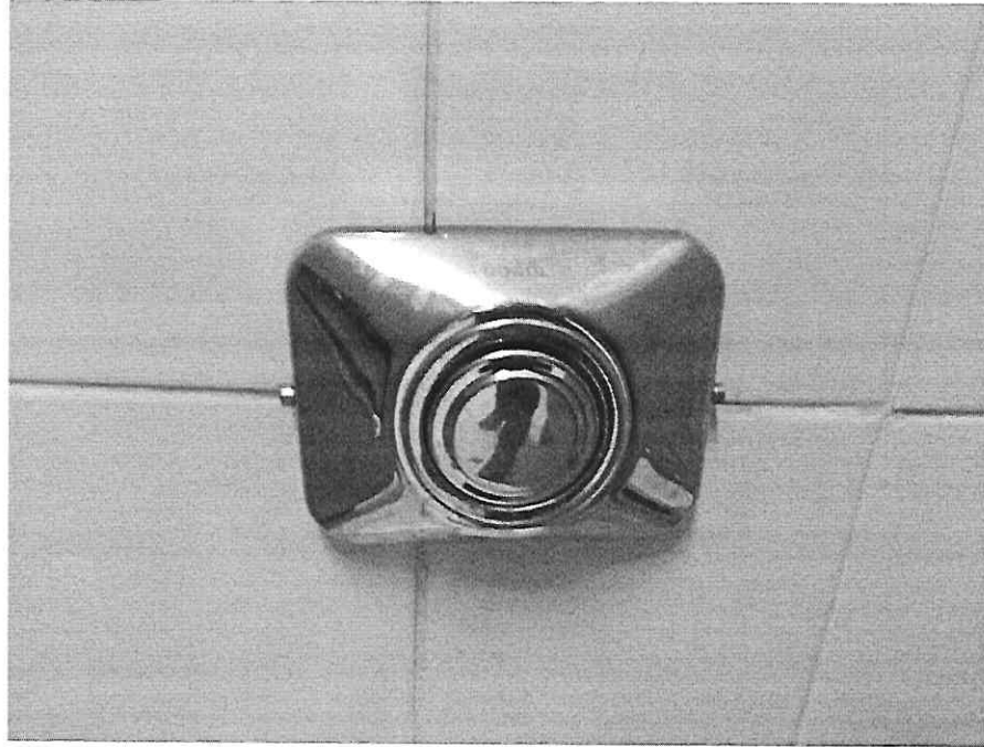
VALVULAS HYDRA INAPROPRIADAS
