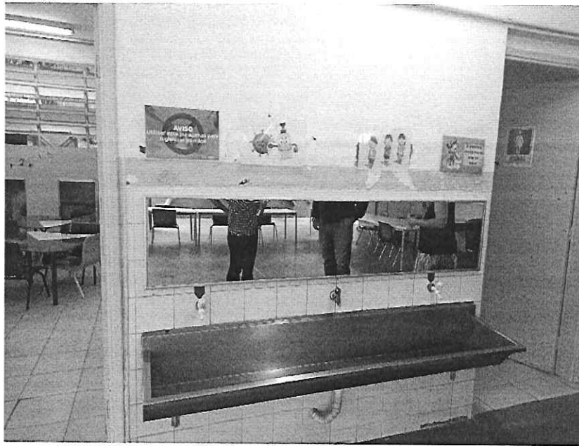
BEBEDOUROS INTERNO E EXTERNO SEM FILTRO
