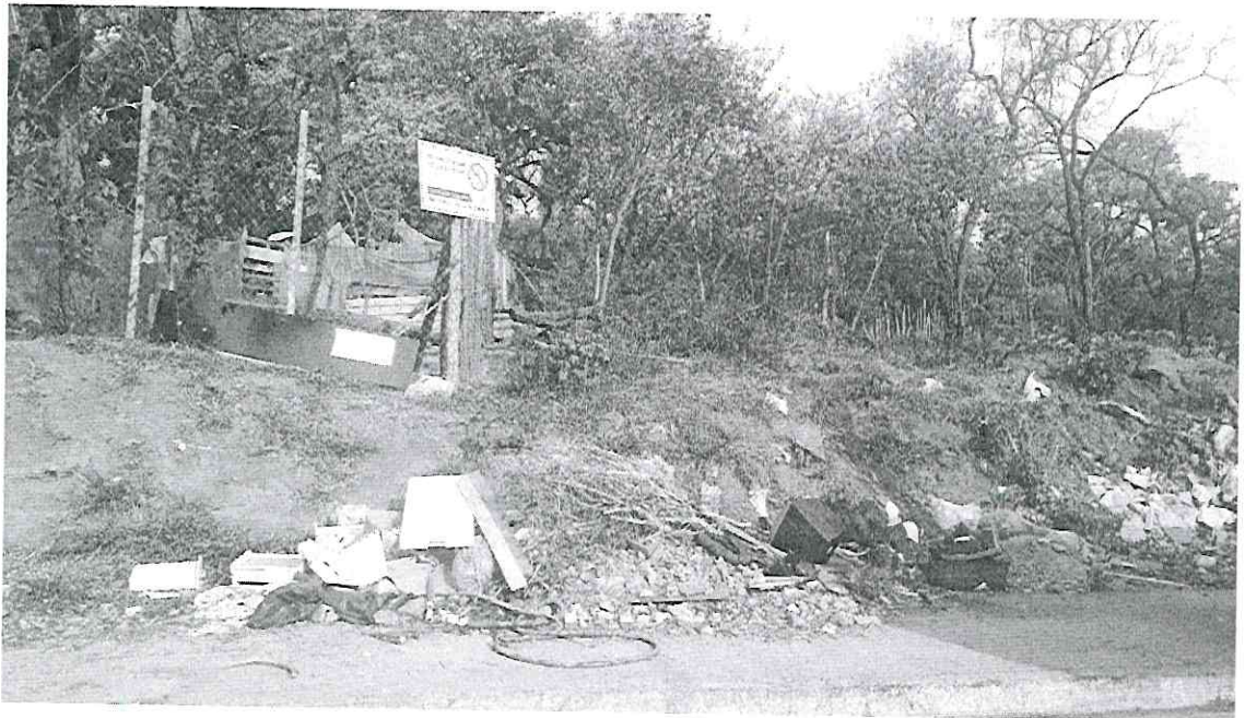
Figura 6 - Na Rua Aparecido Bueno da Silva, vê-se grande quantidade de entulho e cerca invadindo o local.
