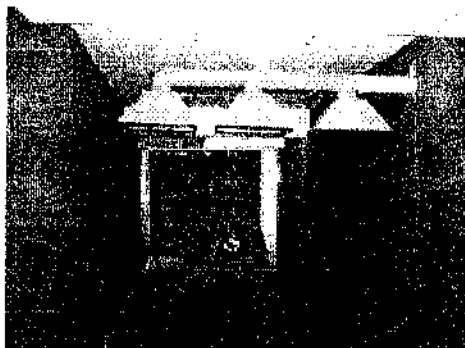
Figura 36 - Aspecto de montagem de exaustores de gases em posição superior e próxima dos atiradores
