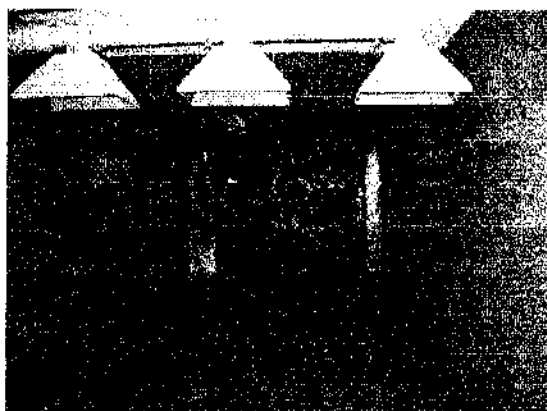
Figura 37 - Outro aspecto de montagem de exaustores de gases em posição superior e próxima dos atiradores
