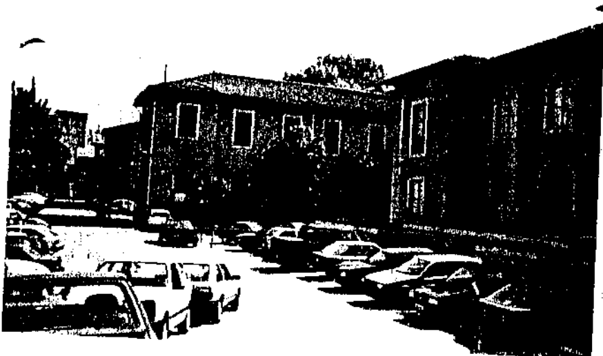
Visão parcial do Umberto I em pleno centro de São Paulo, desativado desde 1993.
