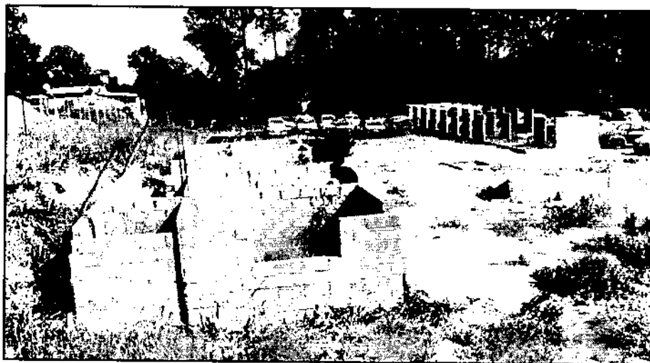
As obras do Canil da Pm foram interrompidas nesta fase
