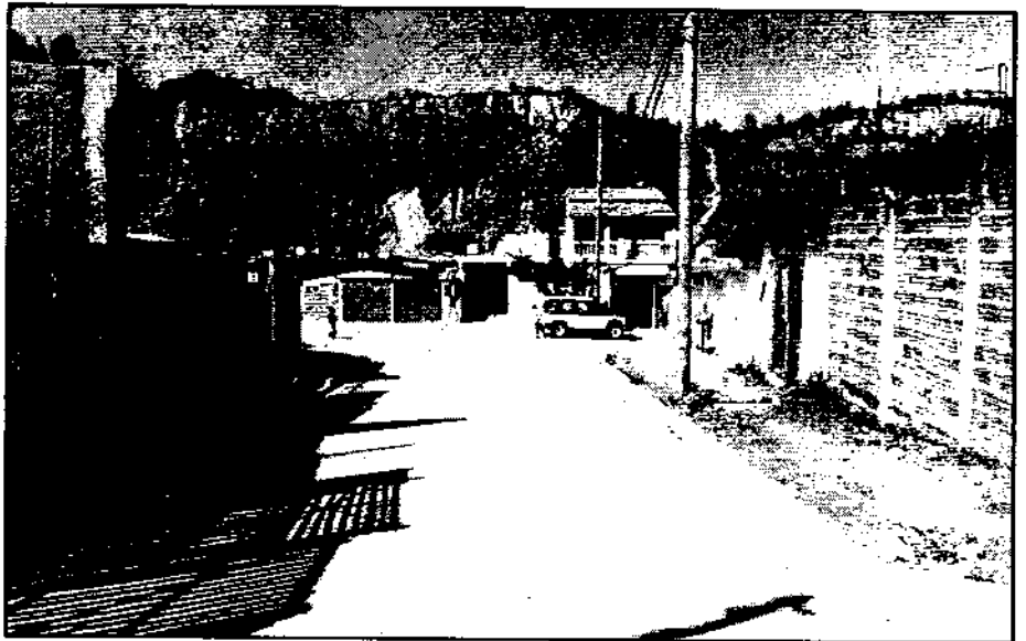
Com o asfalto, as ruas da região dos Morros tornaram-se transitáveis
