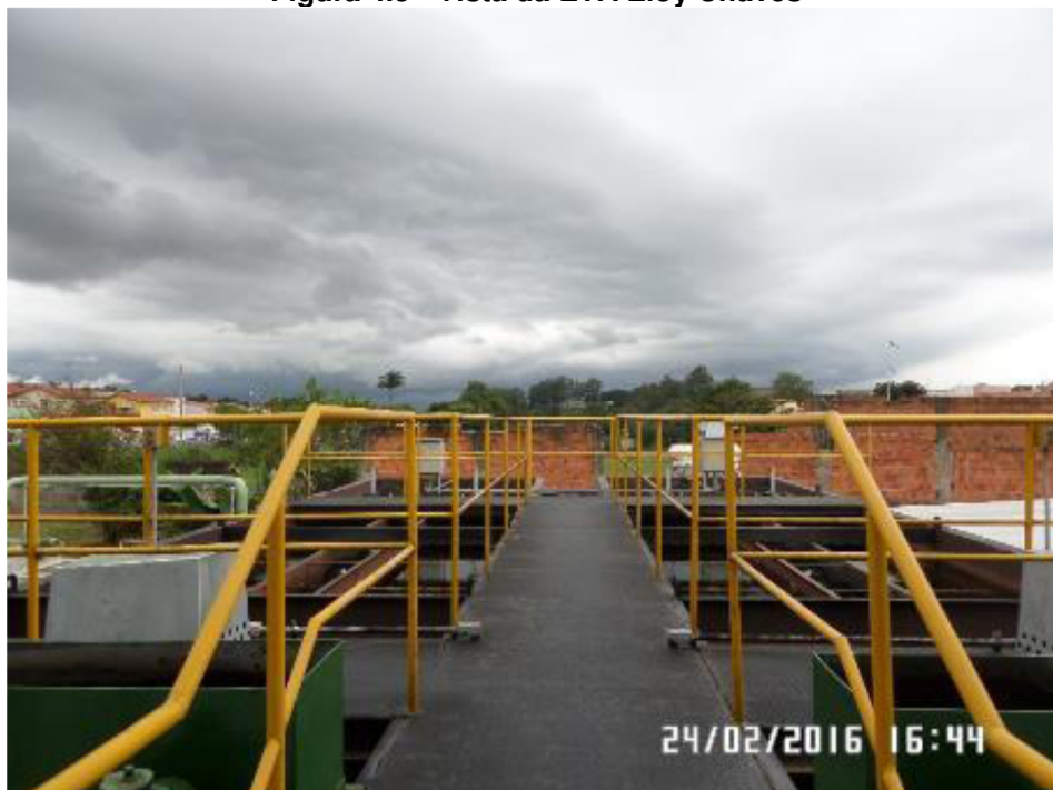
Figura 4.5 - Vista da ETA Eloy Chaves
