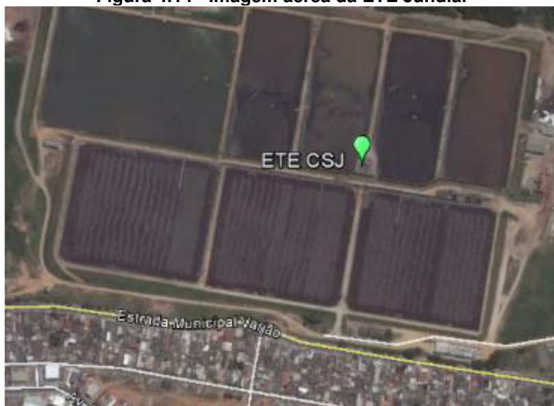
Figura 4.14 - Imagem aérea da ETE Jundiáí
