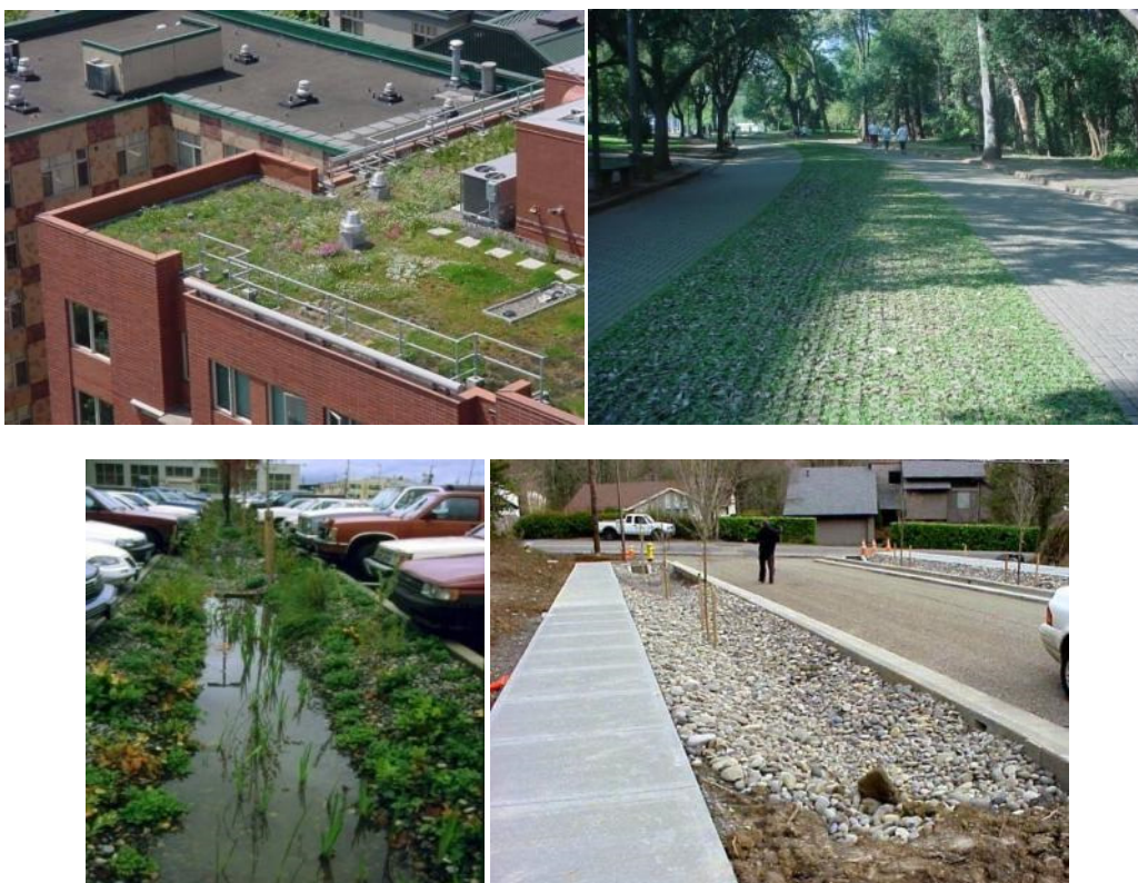
Figura 7.26 - Exemplos de retardamento do escoamento superficial em áreas públicas, Denver (PORTLAND, 2002)
