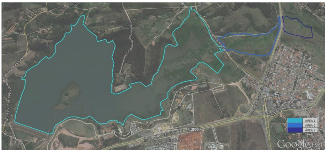
Figura 7.1 – Represa de Acumulação – Parque da Cidade
