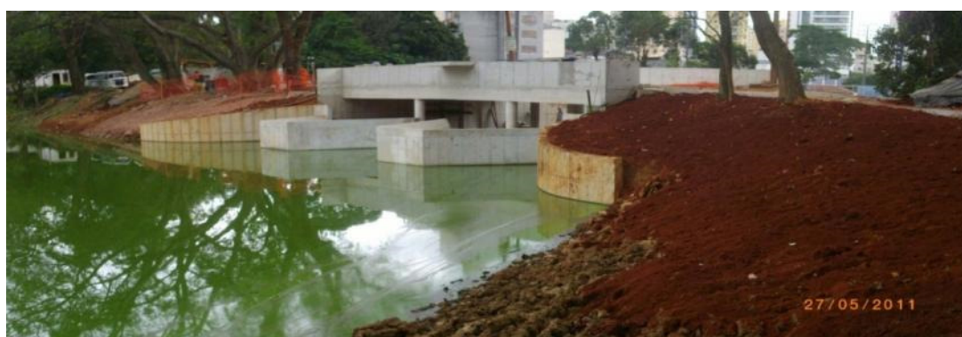
Figura 7.24 - Vertedor Labirinto no Lago da Aclimação
