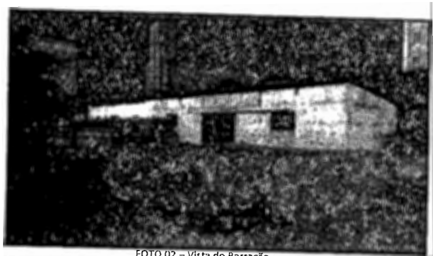
FOTO 02 – Vista do Barracão
